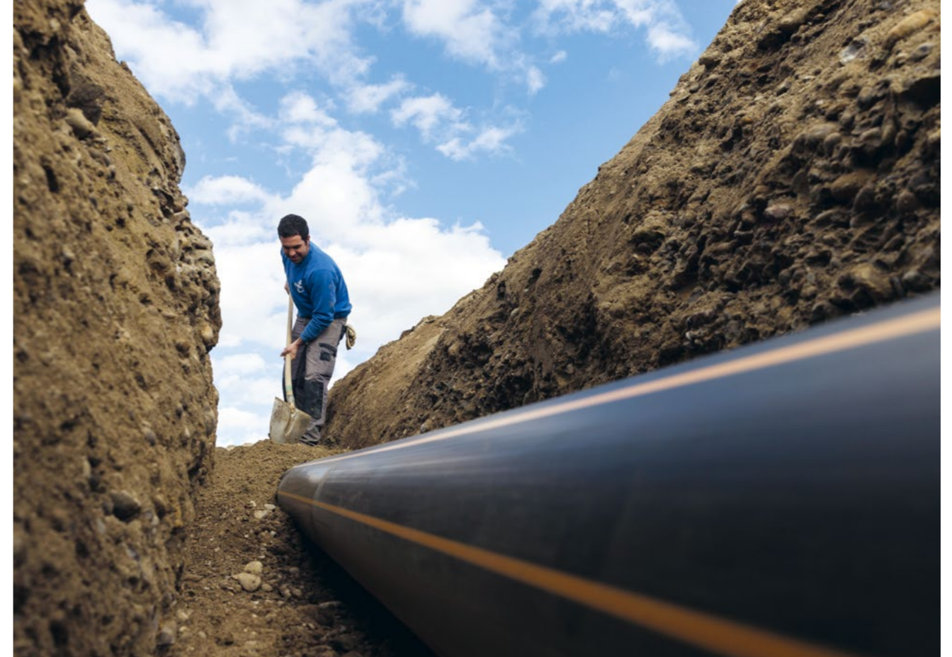
Un gazoduc est installé.
